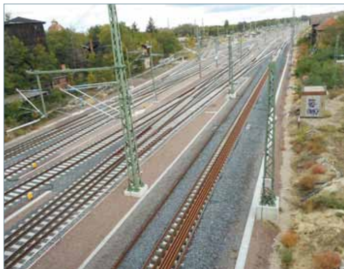
Blick auf die neuen Gleise von Roßlau, Streetzer Brücke, in Richtung Meinsdorf im Oktober 2020. Foto: Andreas Sanow
