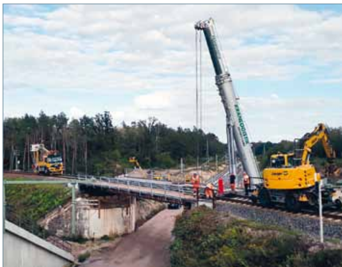
Die Bauarbeiten am Kreuzungsbauwerk der Strecken aus Richtung Wittenberg und Wiesenburg im September 2020 Foto: DB Netz AG
