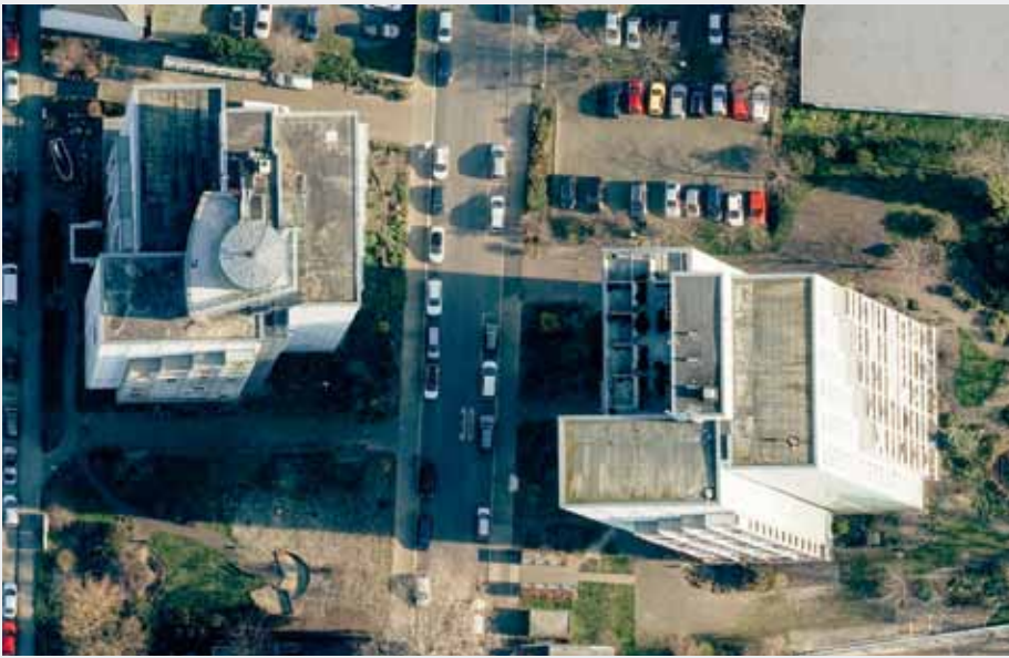
Eine echte Herausforderung im Baufeld des Ersatzneubaus Strombrückenzug sind oft die 16-Geschosser an der Mittelstraße. Eine Naht zwischen diesen offensichtlich aus verschiedenen Fotos stammenden Ausschnitten ist nicht zu erkennen, oder?
