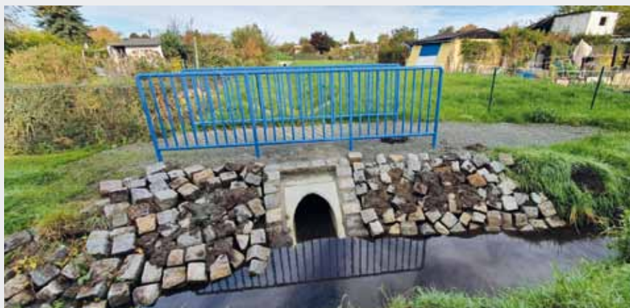
Bild links: Beckenkaskade aus der Vogelperspektive, dahinter befindliche Straßenanlage und Ackerflächen
