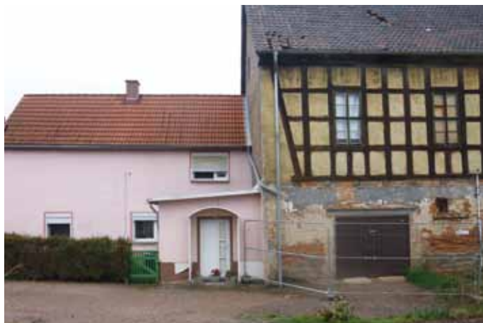
Bestand: älteres, größeres Gebäude 1 (rechts) und jüngeres, kleineres Gebäude 2 (links)
