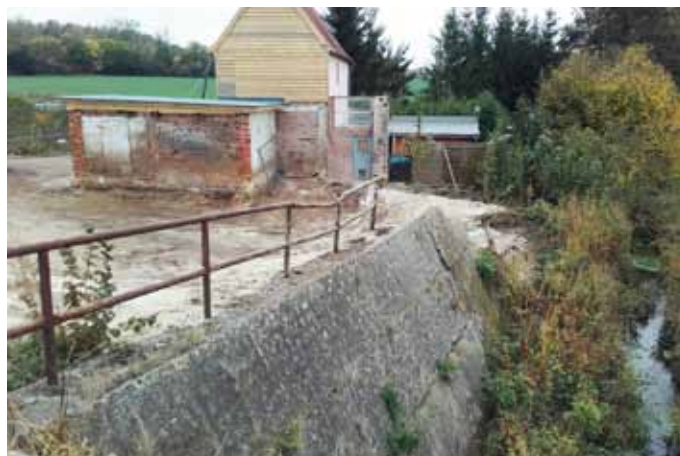
Nach Teilabriss von Gebäude 1 und temporäre Sicherung der Garage und der Giebelwand
